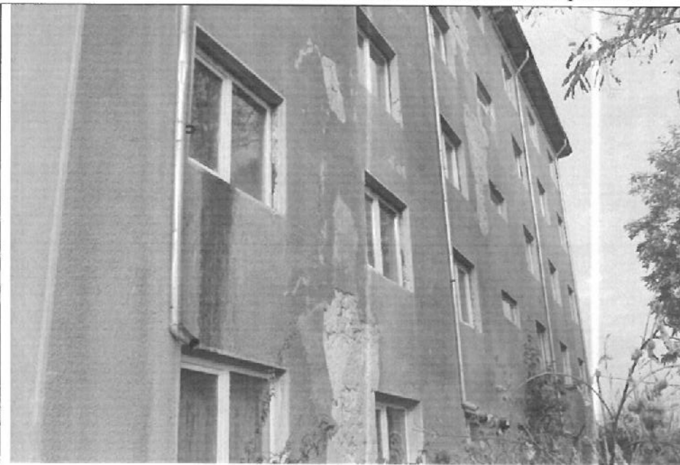
Cladirea internat-vedere laterala cladirea cantina si spalatorie
